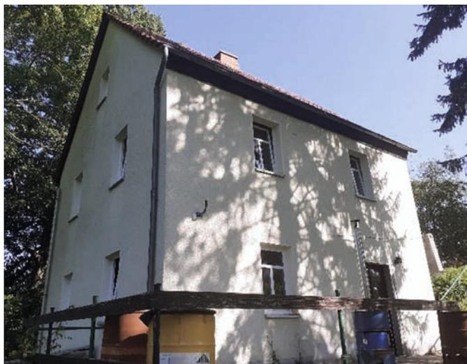
Der momentane bauliche Zustand des Gebäudes ist grundsätzlich solide aber nutzungsbedingt sanierungsbedürftig. Das Mauerwerk ist zum Teil durchfeuchtet, Putz- und Mauerwerksschäden zu verzeichnen, die Innenausstattung (Fußböden, Wände, Decken, Türen etc.) und die Einrichtung sowie die Sanitär-, Heizungs- und Elektroanlagen sind verschlissen. Die Außenanlagen (Treppenanlage, Terrasse etc.) befinden sich in einen maroden Zustand mit erheblichen Unfallgefahren.
