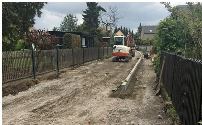
Die Maßnahme umfasste die Erneuerung des Unterbaus in Teilflächen, um die Tragfähigkeit der neu hergestellten Tragdeckschicht zu gewährleisten. Des Weiteren wurde eine Rinne zur Oberflächenableitung in neu angeordnete Abwasserschächte hergestellt. Der ZAL regulierte bzw. erneuerte die Schieber der Trinkwasseranlage.
