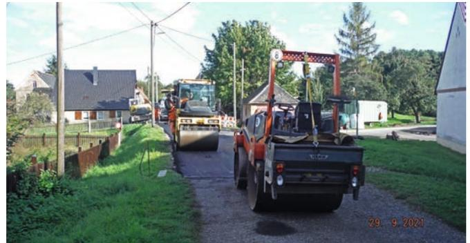
Dabei wurde auf einer Fläche von ca. 650 m<sup>2</sup> eine neue Asphalttragdeckschicht hergestellt. Zusätzlich konnten im Zuge der Maßnahme einige Projekte des ansässigen Dorf- und Verschönerungsvereins realisiert werden.
