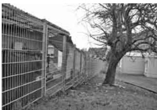
Noch im November des vergangenen Jahres konnten in der Kita Lehndorf ca. 40 m der noch alten Grundstückseinfriedung durch einen neuen Stahlgitterzaun (mit Abdeckleiste, feuerverzinkt, pulverbeschichtet in grau RAL 7030, Pfosten, Doppelstabmatte) ersetzt bzw. wie im Bestand ergänzt werden.
